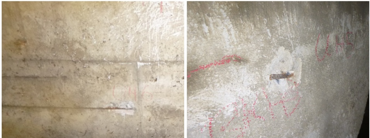
Bild 3: Beispiele für lokale Abplatzungen mit freiliegender Bewehrung an Wänden
