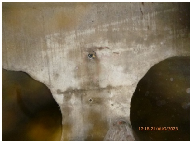
Bild B9: Bohrkernentnahmestelle BK H3
