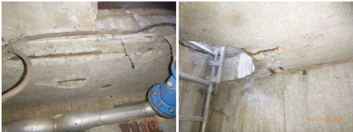
Bild 1: Beispiele für freiliegende Bewehrung an der Deckenuntersicht^
