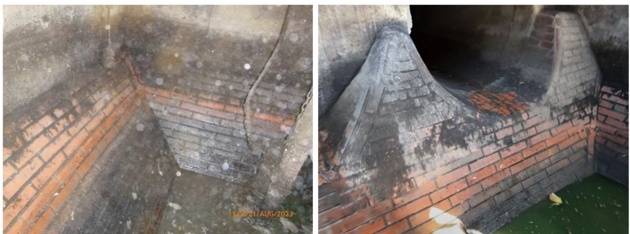
Bild 4: Beispiele für augenscheinlich intakten Kanalklinker mit ausgeprägten Schmutzablagerungen
